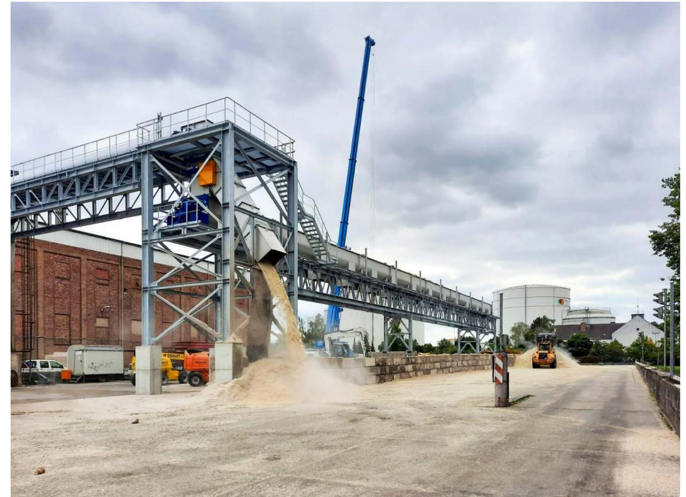
Ursprünglich wollte die Cosun Beet Company ein stör anfälliges und an der Leistungsgrenze operierendes System durch einen verfahrenbaren, reversierbaren Muldengürtelförderer ersetzen. Daraufhin hat unser Team alternative Lösungen aufgezeigt und eine Matrix erarbeitet, in der die Vor- und Nachteile von unterschiedlichen Systemen erläutert wurden. Auf diese Weise hat sich ein System herauskristallisiert, das besonders betriebssicher und wartungsarm ist.
